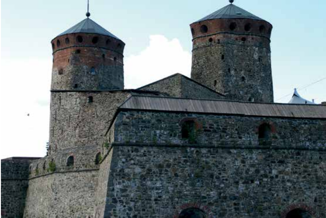
Olavinlinnan kivirakenteita. Kuva Leena Lahdenvesi-Korhonen.
