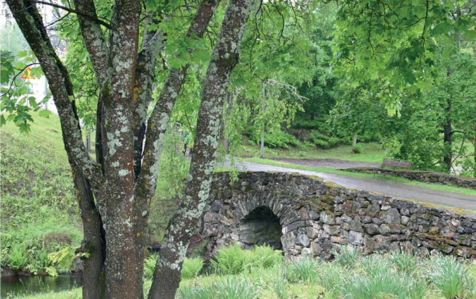
Enonkosken 1900-luvun alussa rakennettu kiviholvisilta on esimerkki hyvin kehittyneestä kylmämuuraustekniikasta. Kuva Leena Lahdenvesi-Korhonen.
