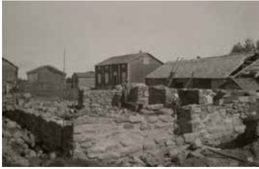
Kivinavetan rakennustöitä vuonna 1931. Kuva Kustaa Vilkuna, Museoviraston kansatieteen kuvakokoelma.
