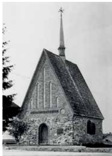
Etelä-Savon vanhin laastilla muurattu kivirakennus on Mikkelin Savilahden Kivisakasti, jonka arvellaan olevan 1400- tai 1500-luvulta. Rakennus sai nykyisen asunsa 1800–1900-lukujen vaihteessa tehdyissä korjaustöissä. Kuvissa rakennus ennen ja jälkeen korjaustöiden. Kuvat Suur-Savon museon kokoelma.
