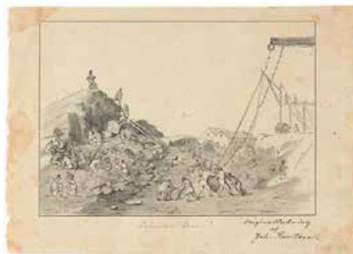
Saimaan kanavan rakentaminen vuosina 1845–1856 oli aikansa suurin kivirakennustyömaa Suomessa. Piirros Johan Knutson, Museoviraston historian kuvakokoelma.
