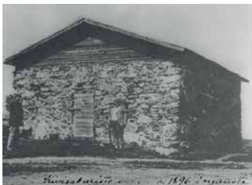
Etelä-Savon vanhin laastilla muurattu kivirakennus on Mikkelin Savilahden Kivisakasti, jonka arvellaan olevan 1400- tai 1500-luvulta. Rakennus sai nykyisen asunsa 1800–1900-lukujen vaihteessa tehdyissä korjaustöissä. Kuvissa rakennus ennen ja jälkeen korjaustöiden. Kuvat Suur-Savon museon kokoelma.
