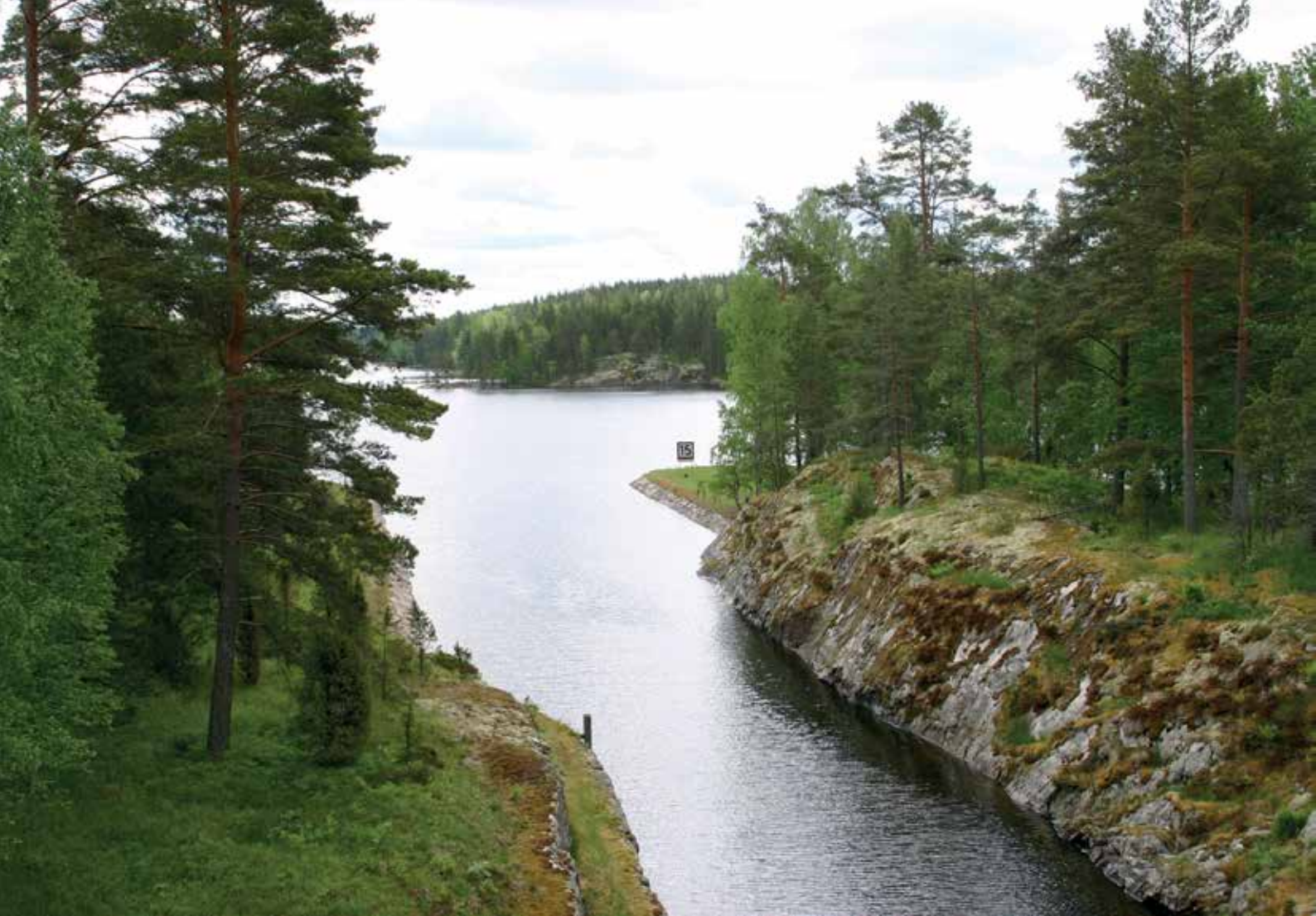
Varkaantaipaleen kanavaa reunustavat jylhät kalliot, joiden väliin kanava on louhittu. Kuva Leena Lahdenvesi-Korhonen.
