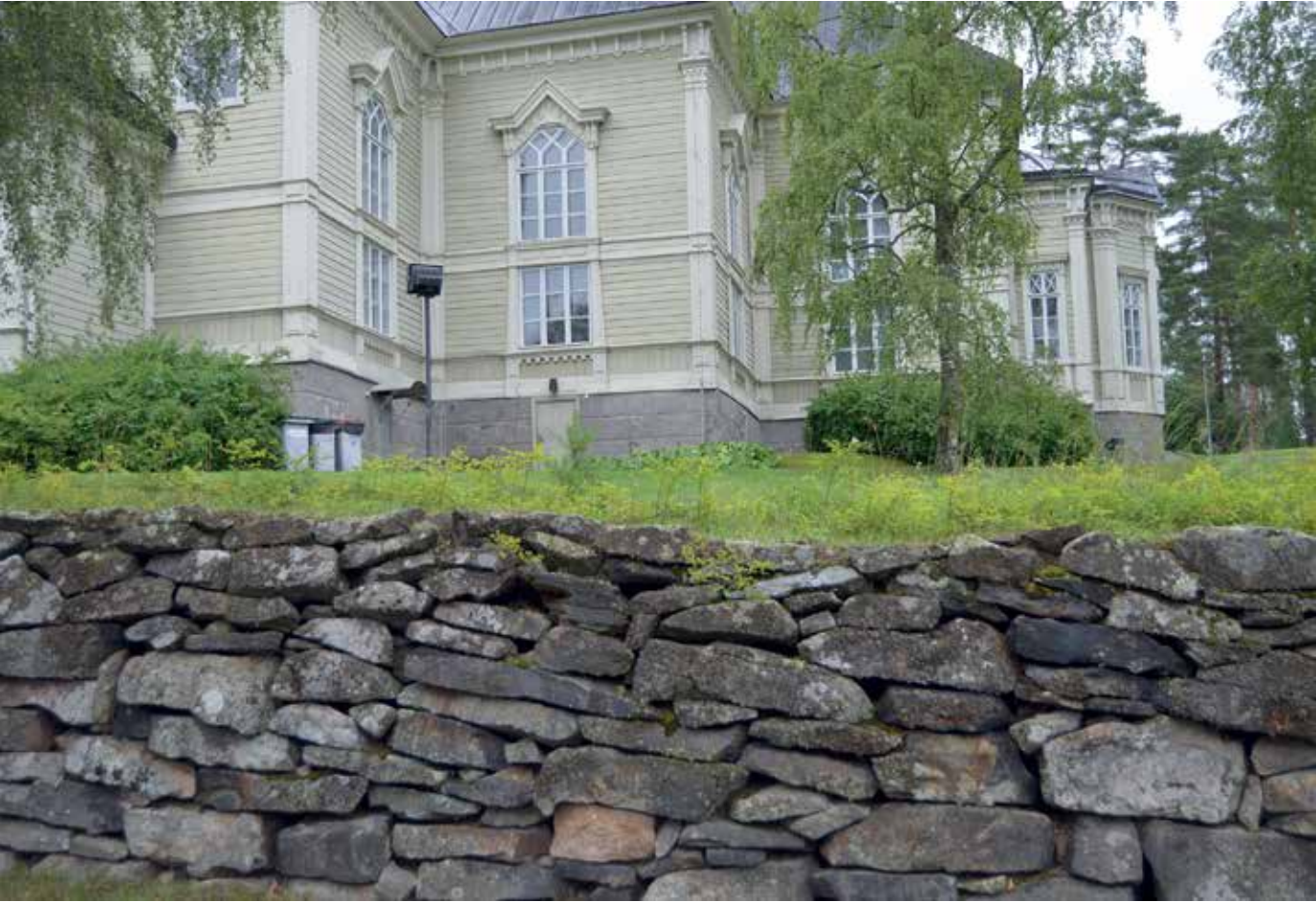
Kangasniemen kirkon kirkkomaata ympäröivä aita on rakennettu kylmämuuraamalla. Kuva Eeva-Liisa Newonen.
